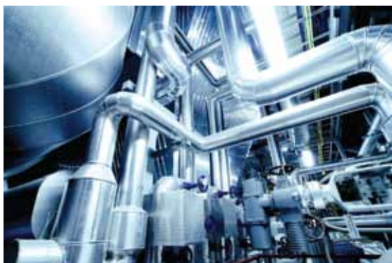
Pomiar bezkontaktowy gęstości przez rurę instalacji
